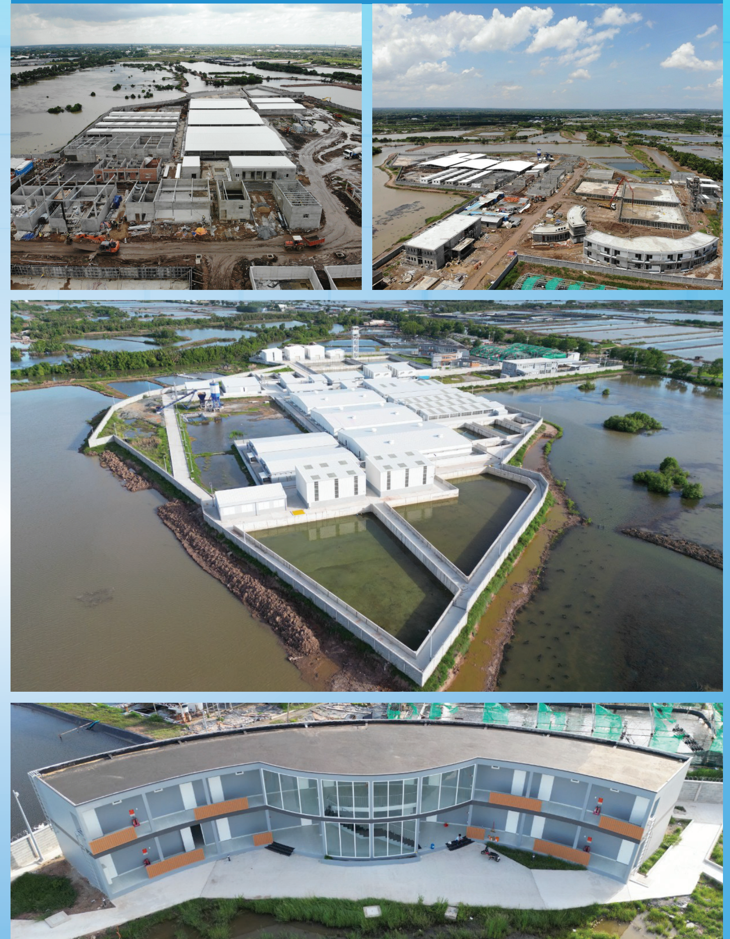
Thi Công Dự Án Trại Tôm Giống Farm Bến Tre 4 - Bến Tre Construction of Ben Tre Farm 4 Shimp Hatchery - Ben Tre Province
