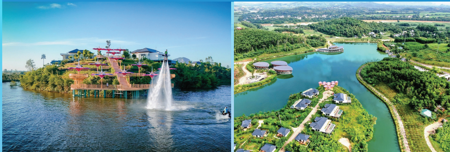
Thi Công Dự Án Resort Sao Mai Thanh Hoá Construction of Sao Mai Thanh Hoa Resort Project
