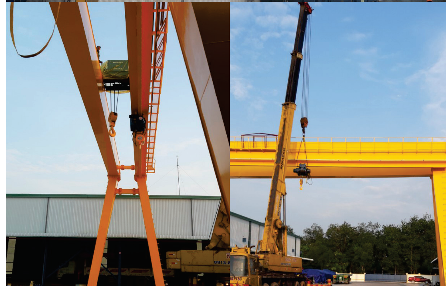
CÔNG CẦU TRỤC Gantry crane
