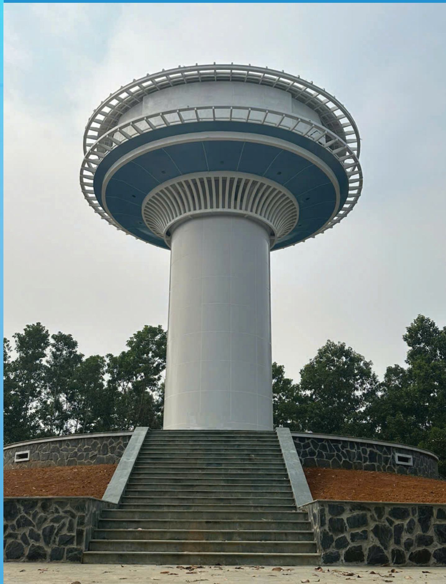
Thi Công Dự Án Resort Sao Mai Thanh Hoá Construction of Sao Mai Thanh Hoa Resort Project
