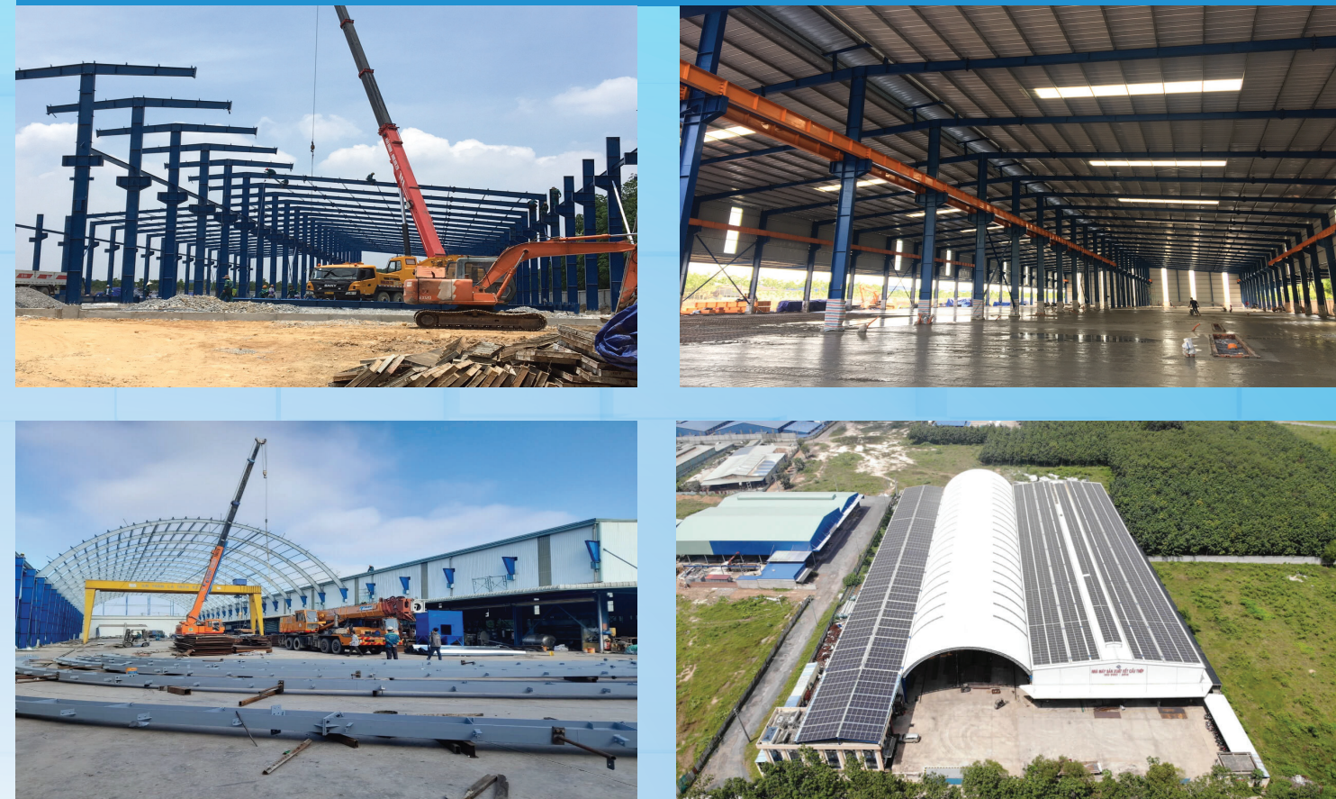
Thi Công Dự Án Nhà Máy Sản Xuất Kết Cấu Thép - Tân Uyên - Bình Dương Construction of Steel Structure Factory - Tan Uyen - Binh Duong Province
