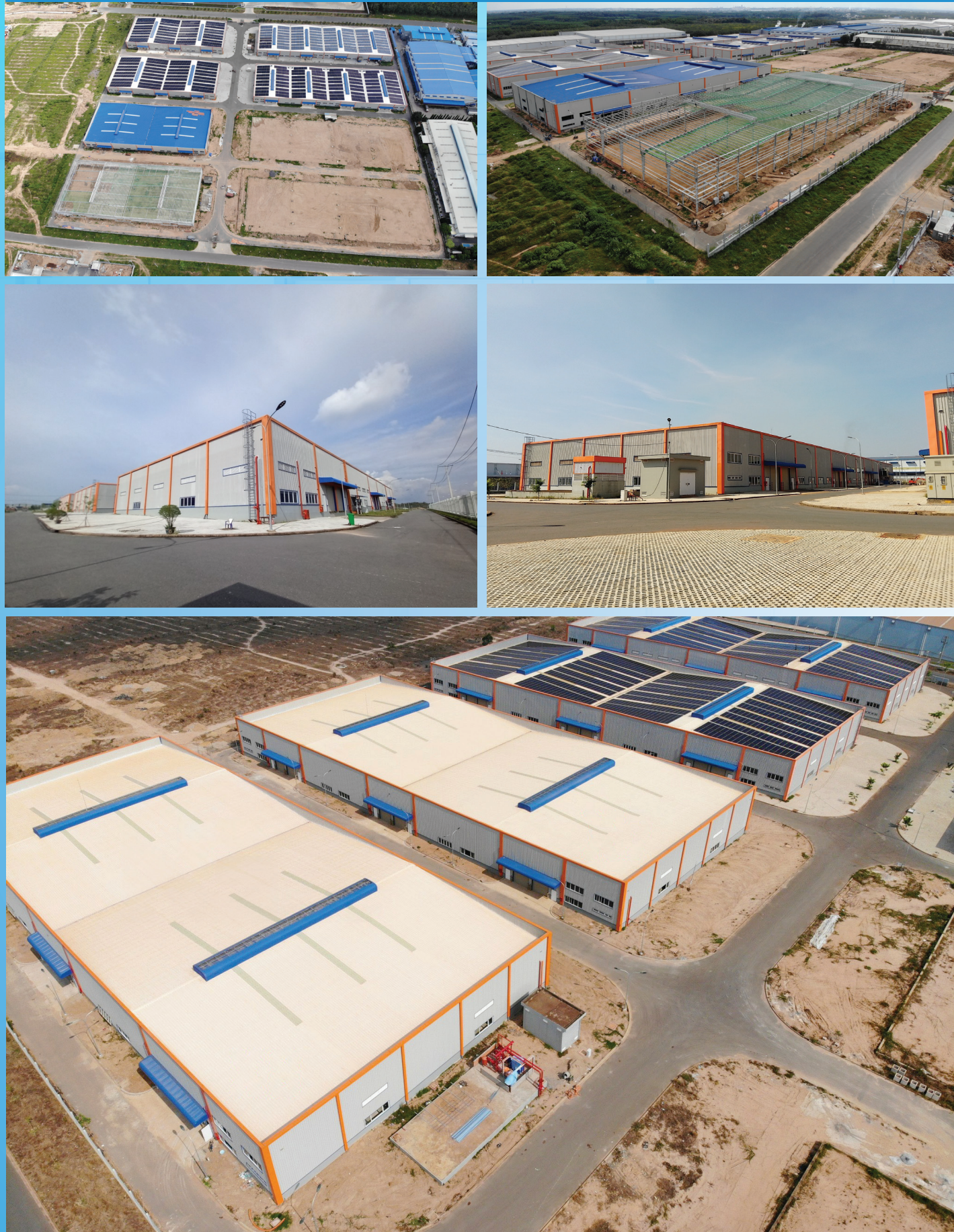
Thi Công Dự Án Nhà Xưởng Cho Thuê - KCN Lộc An - Bình Sơn, Long Thành, Đồng Nai Construction of Warehouse for rent in Loc An - Binh Son Industrial Park, Long Thanh, Dong Nai Province
