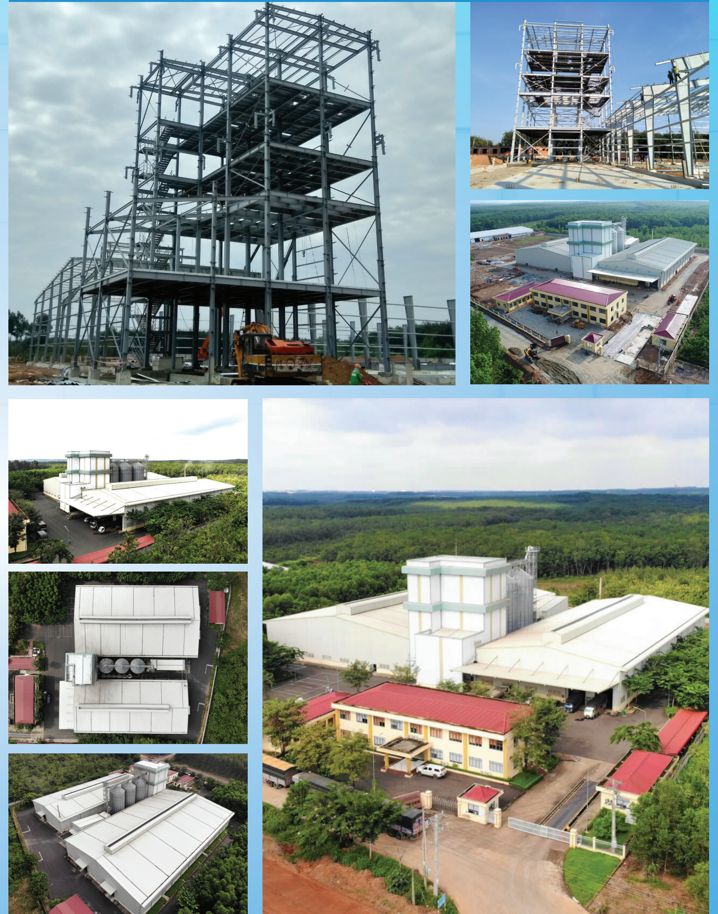
Thi Công Dự Án Nhà Máy Thức Ăn Dabaco - Bình Phước Construction of Dabaco Food Factory - Binh Phuoc Province
