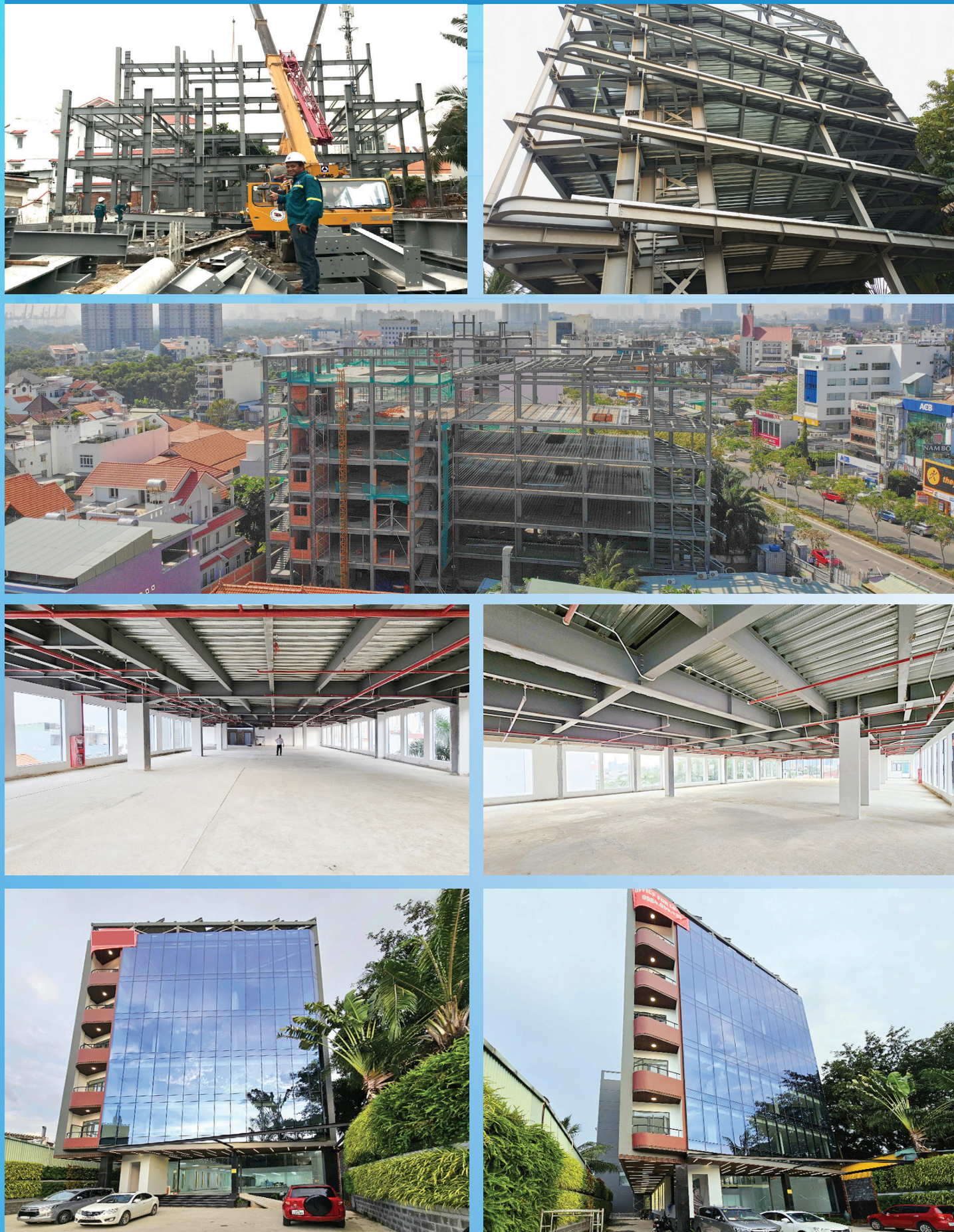
Thi Công Dự Án Toà Nhà Văn Phòng Tập Đoàn LDG - TP Thủ Đức - TP HCM Construction of Office Building of LDG Group - Thu Duc City - Ho Chi Minh City
