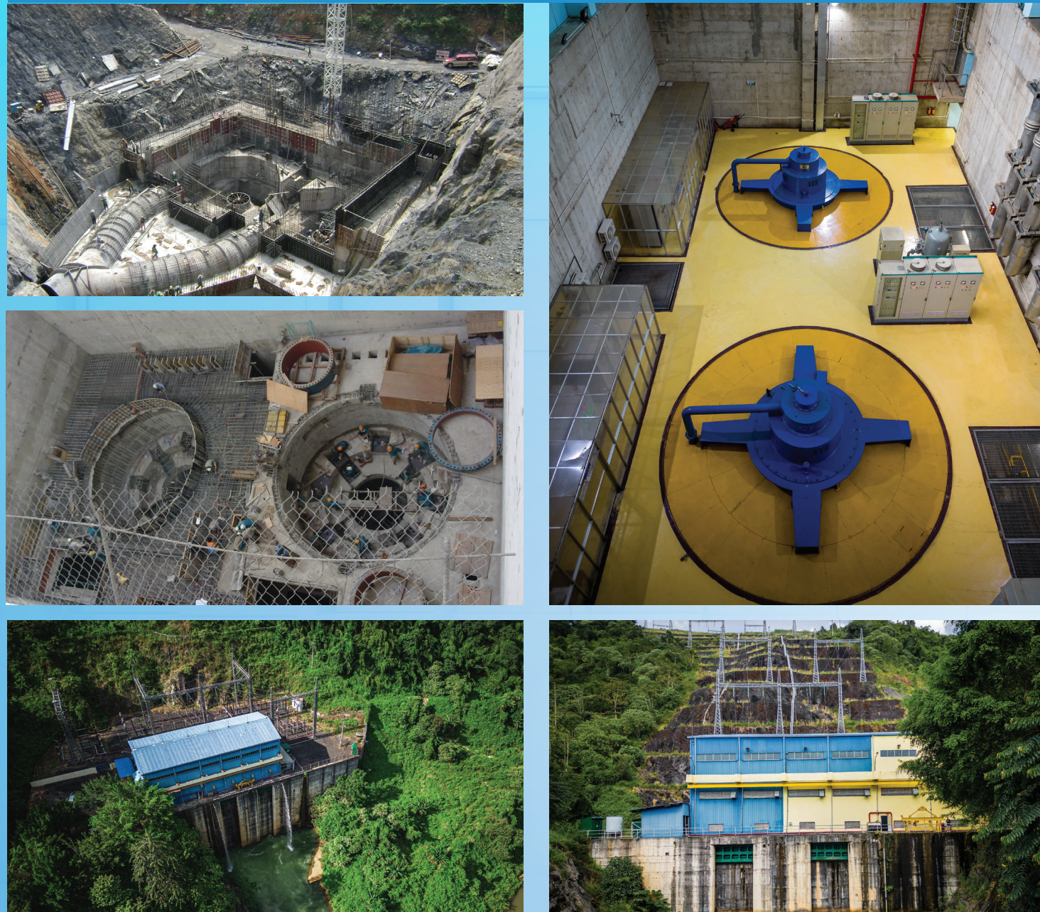
Dự Án Nhà Máy Thủy Điện Đak R'Tith / Dak R'Tith Hydropower Plant Project
