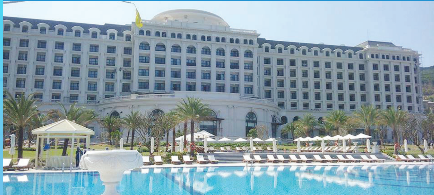
Cung Cấp Lắp Đặt Hệ Thống M&E Dự Án Khách Sạn Đầm Già - Nha Trang Supplied and installed of M&E system Dam Gia Hotel - Nha Trang City
