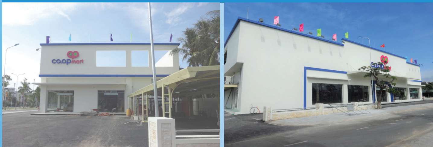
Thi Công Dự Án Siêu Thị Co.op Mart Hà Tiên - Kiên Giang Construction of Ha Tien Co.op Mart Supermarket in Kien Giang Province
