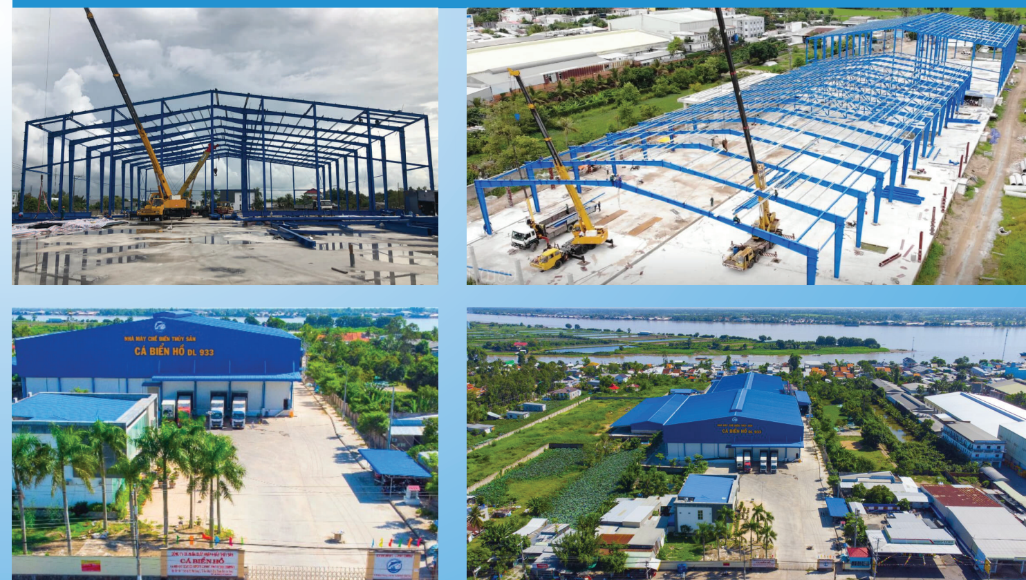
Thi Công Dự Án Nhà Máy Chế Biến Thủy Sản Cá Biển Hồ - An Giang Construction of Bien Ho Fish Seafood Processing Factory - An Giang Province
