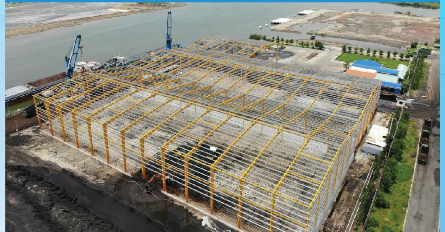
Thi Công Dự Án Kho Chứa Hàng - Cảng Nội Địa Phú Mỹ và Kho Cảng Tổng Hợp Construction of Warehouse - Phu My Inland Waterway Port and General Port Warehouse Phu My, Ba Ria - Vung Tau Province
